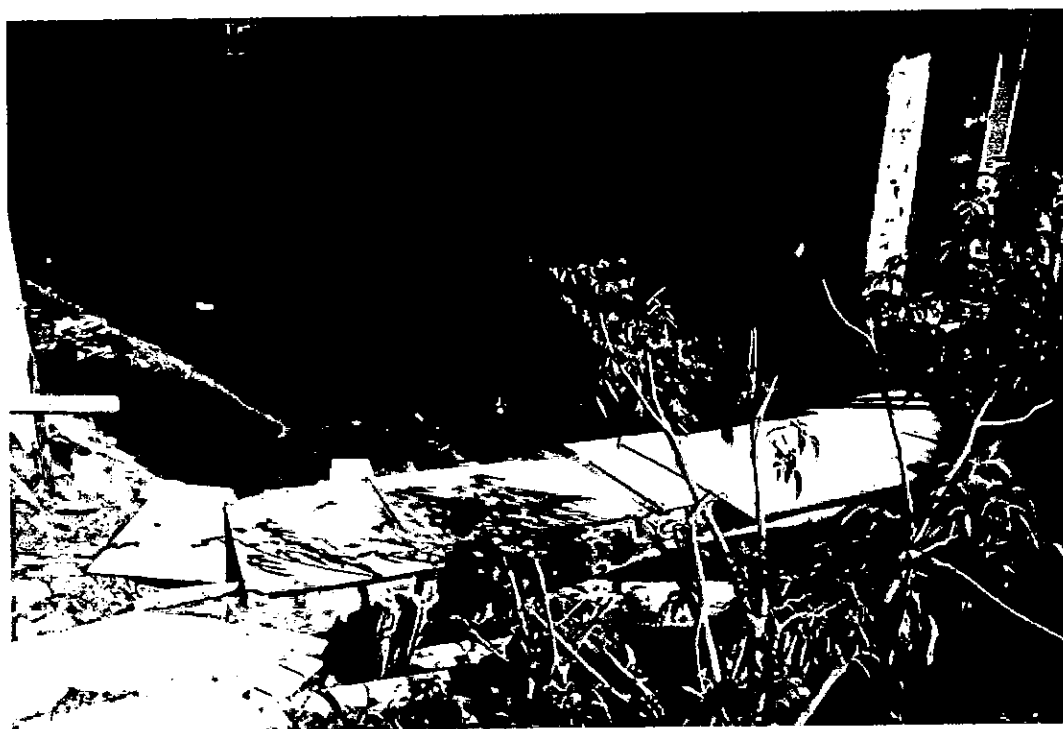
Ponte – Perigo na travessia de usuários e transeunte
