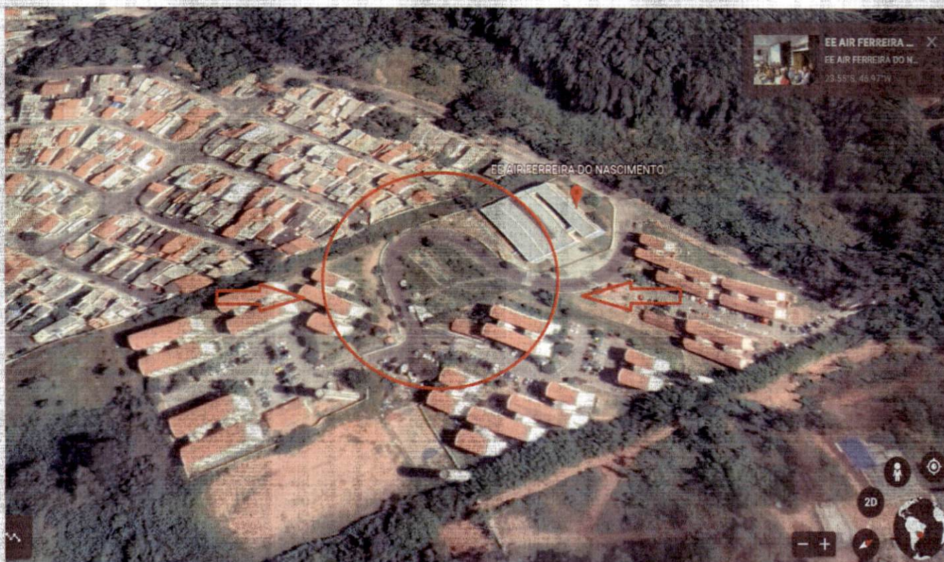
ESTRADA ELIAS ALVES DA COSTA – CDHU – VILA SANTA FLORA
