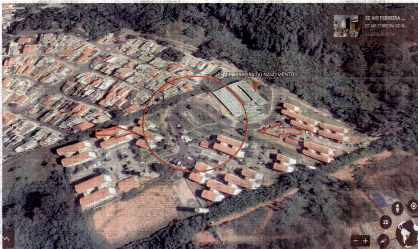
ESTRADA ELIAS ALVES DA COSTA (VILA SANTA FLORA)
