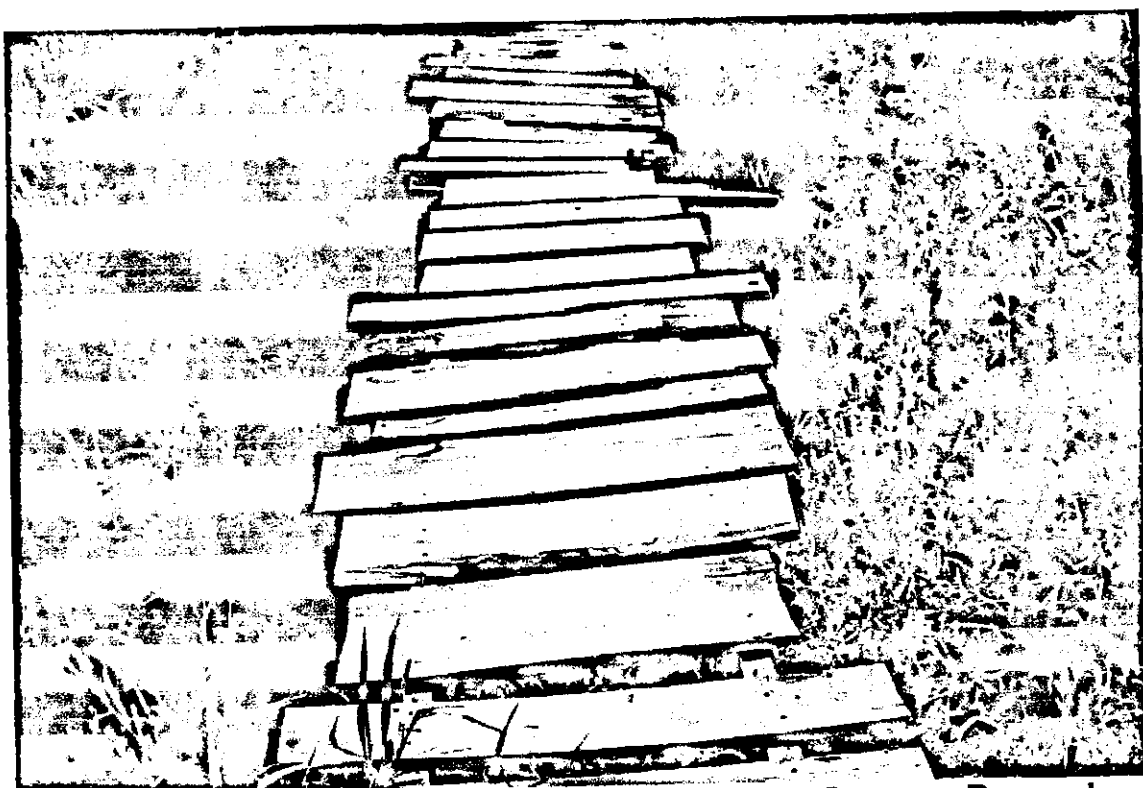
Jardim São Carlos – Córrego entre as Ruas Carpa e Dourado (Ponte de madeira oferece risco aos transeuntes)
