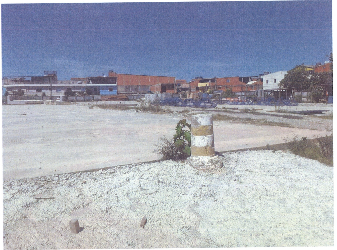
Rua Sideral altura do altura do nº 590 – Jardim Vitapolis Construção de Moradias Populares
