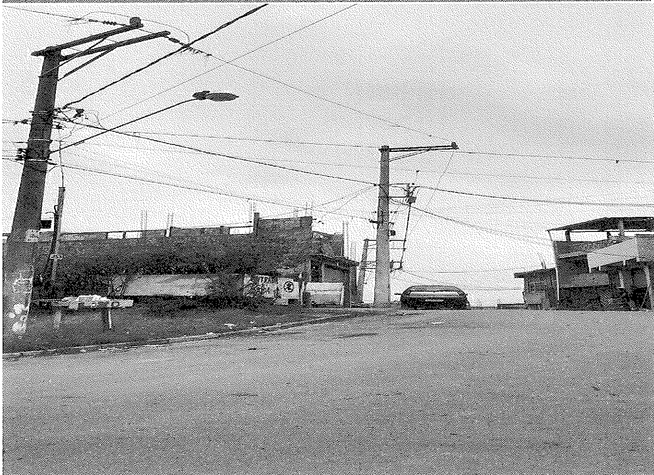
Rua da Mangabas prolongamento rede iluminação publica nº 260 ao 364 Vitápolis
