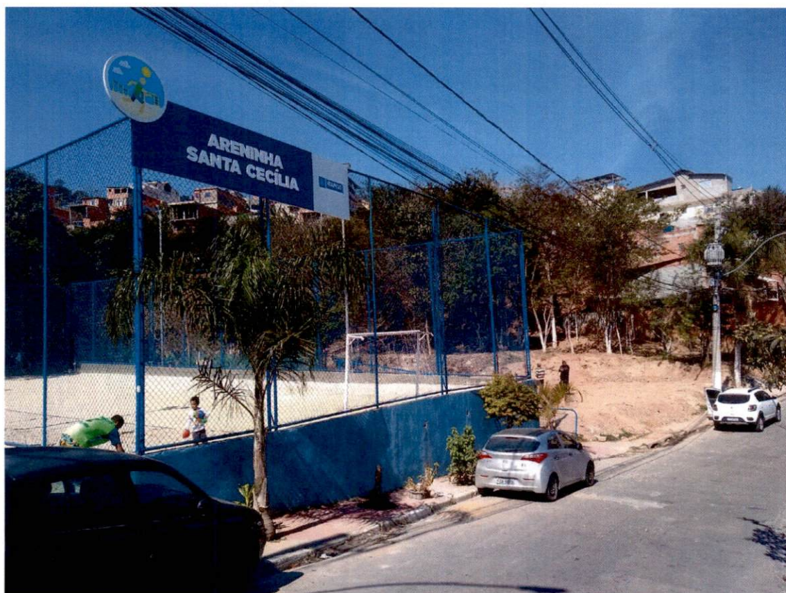
Revitalização e Reforma da Quadra de Futebol situada na Rua Maria Salete Gomes no Bairro Chácara Santa Cecília - Itapevi
