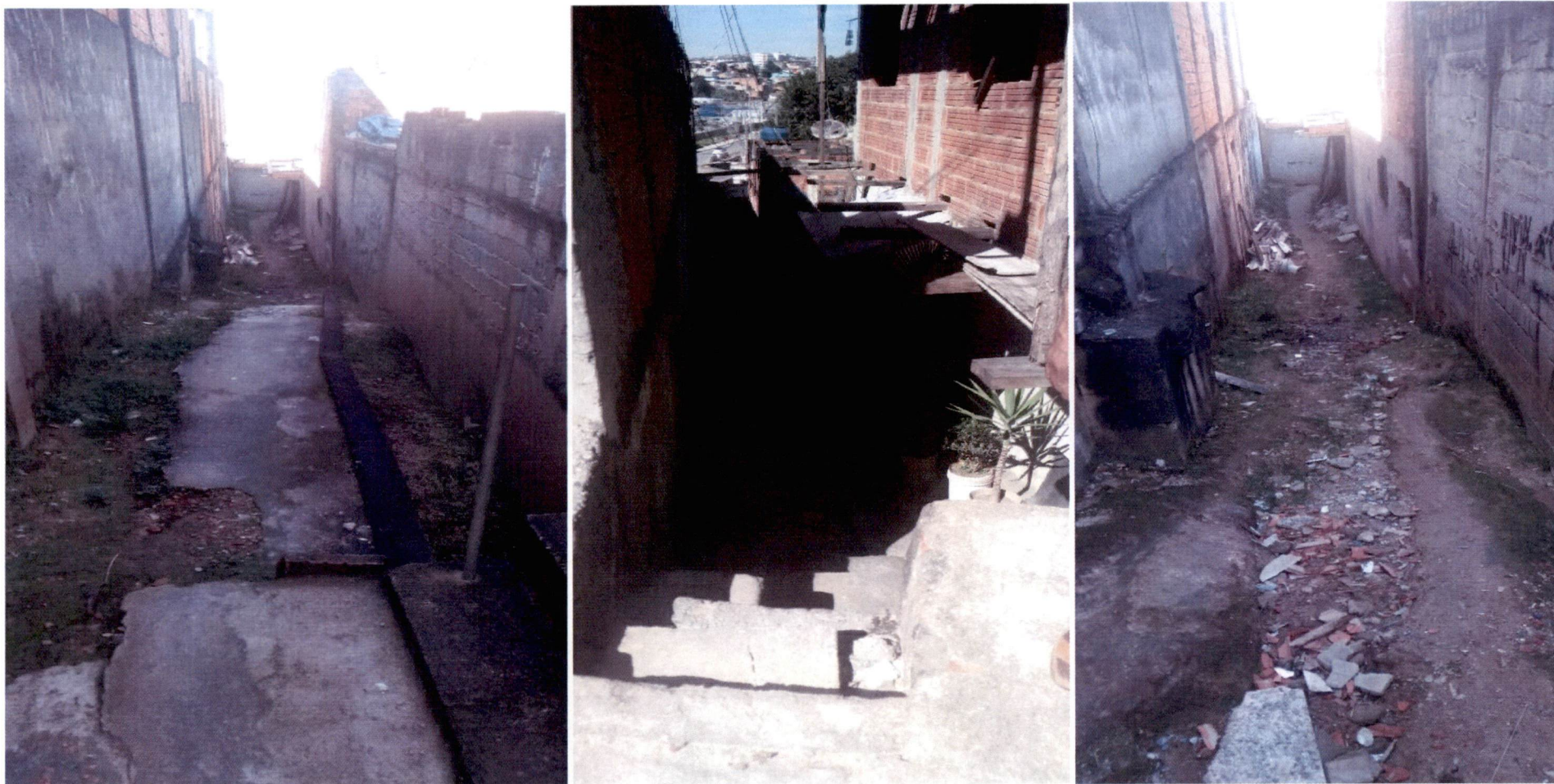
Concretagem na extensão da Viela Astral – Jardim Vitápolis.
