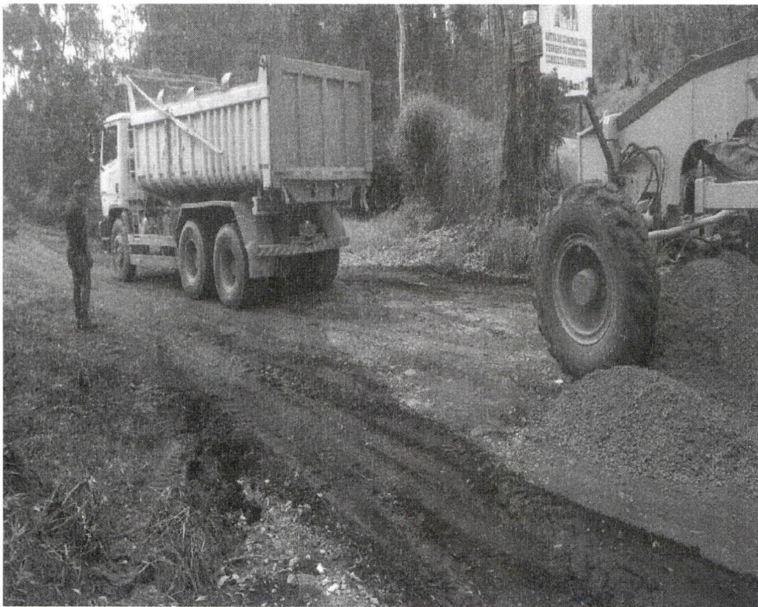
Estrada pedreira pavimentação recanto da pedras
