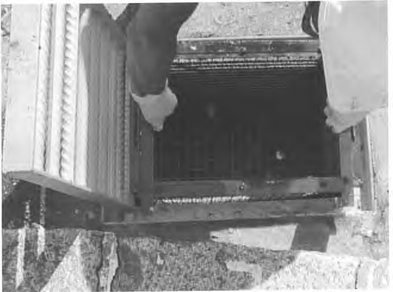
Novos bueiros com filtros são instalados para evitar alagamentos em Poços de Caldas (Foto: Reprodução EPTV)
