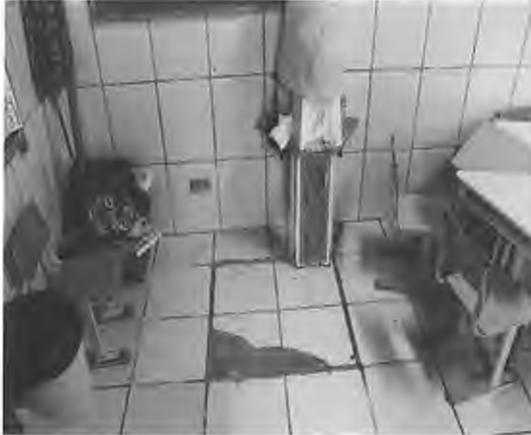
Acesso a caixa de esgoto e a infiltração por ela causada
