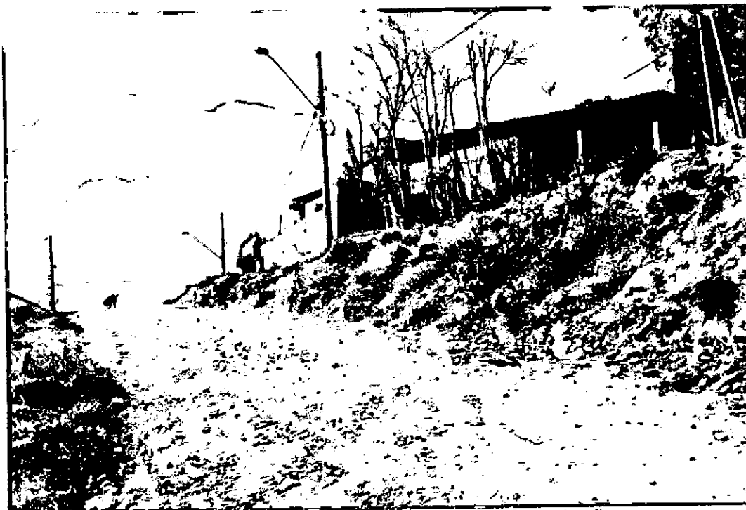
FOTOS 1, 2 e 3 - Rua Sergipano - Pavimentação
