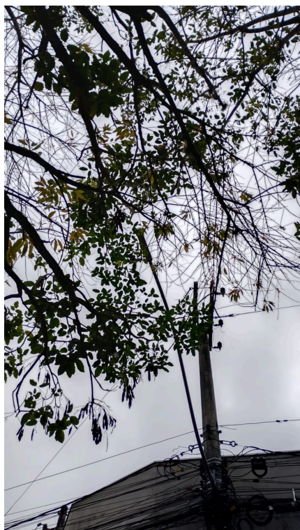
Figura 2: Detalhe para a obstrução de luminária pública.
