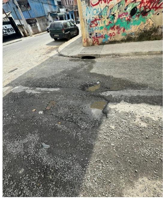
Portanto, é necessário que, o quanto antes, ocorra o devido recapeamento para que o asfalto de toda a extensão da rua fique uniforme. Desta forma, dará aos moradores melhores condições de transitar pela rua sem que haja riscos de encontrarem buracos ou desnivelamento.
