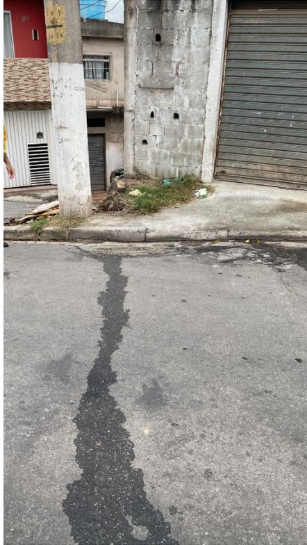
Para solucionar este problema, é necessário que ocorra a devida construção do sarjetão, sendo colocado nos pontos baixos ou no encontros dos leitos viários, assim, toda a água superficial será conduzida da faixa pavimentada e da faixa de passeio ao dispositivo de drenagem.
