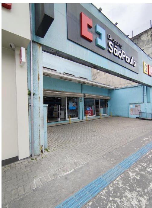
Foto 02: Reparo no passeio
