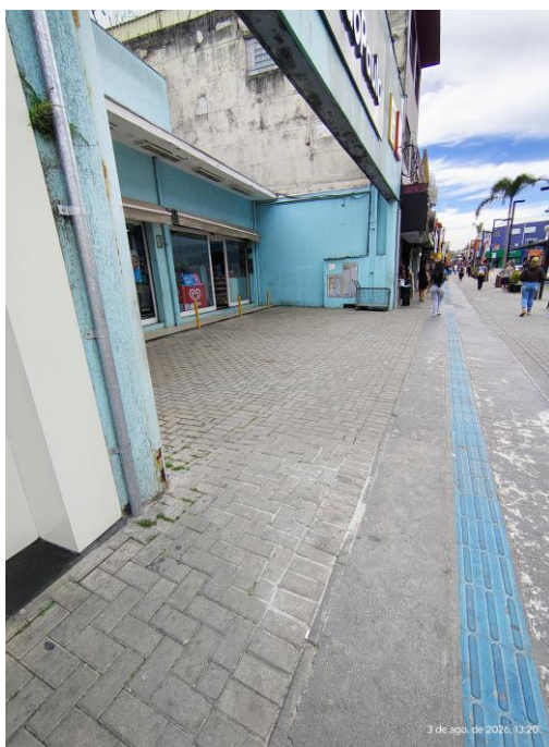
Foto 01: Reparo no passeio
